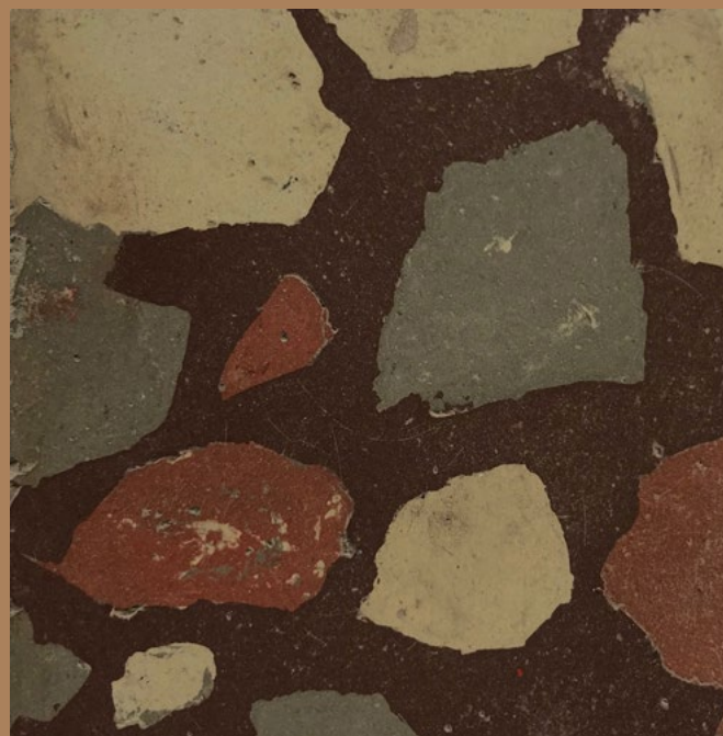
Imitacja zlepieńca „zygmuntówka” wykonana z zaprawy Multispachtel Imitation of „zygmuntówka” made of Multispachtel mortar (fot. Ewa Porzyć)
