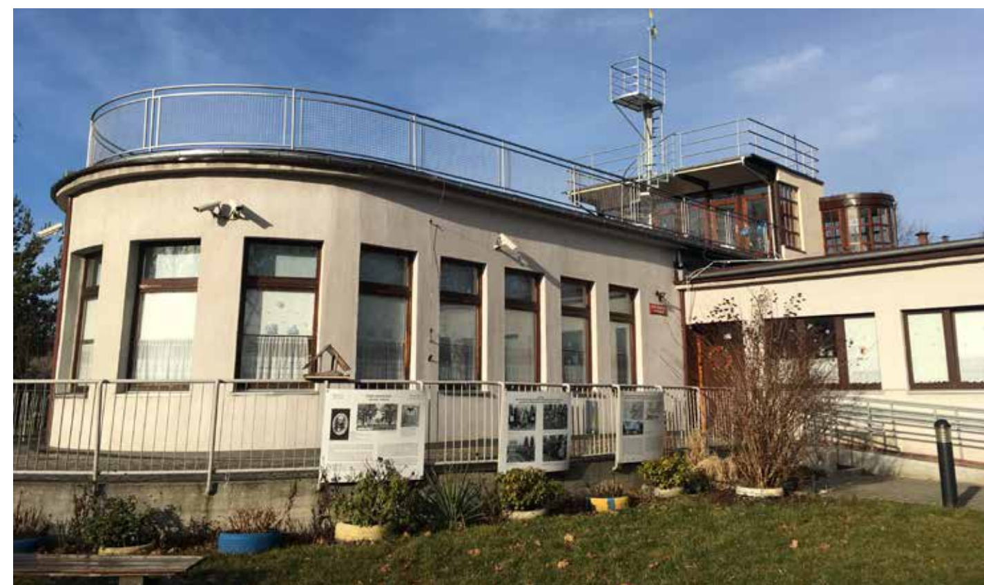
Miejskie Przedszkole nr 3 w Katowicach, ul. Barbary 25. Elewacja południowa, część wschodnia, odtworzone elementy bryły [fot. A. Kaprzyk]
