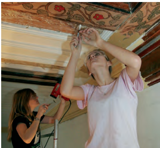
Sala im. Ludwika Kolankowskiego w trakcie prac konserwatorskich, 2007–2008
